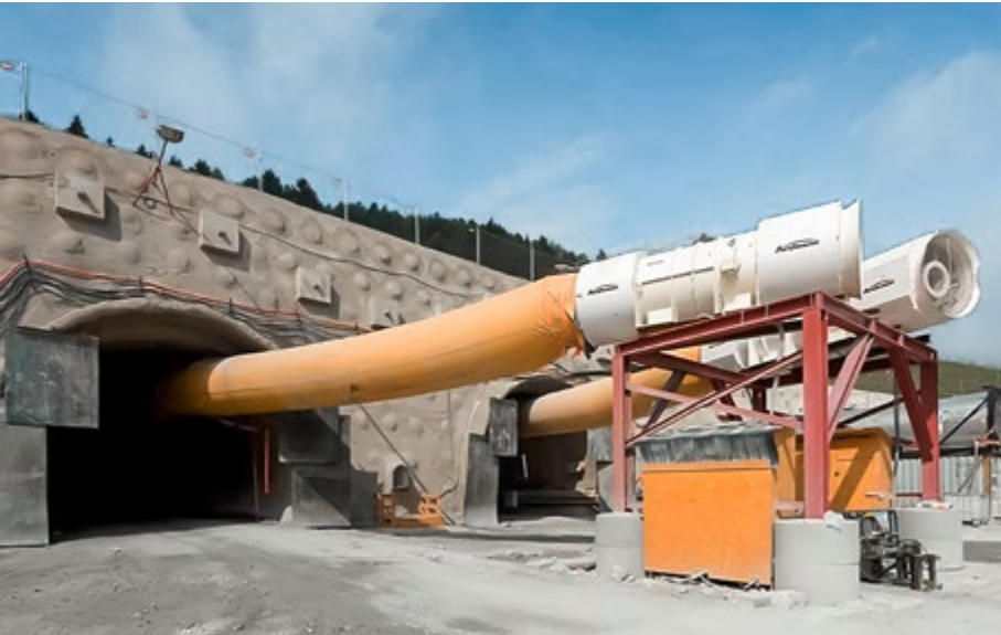
Das Tunnelportal in Gloggnitz
