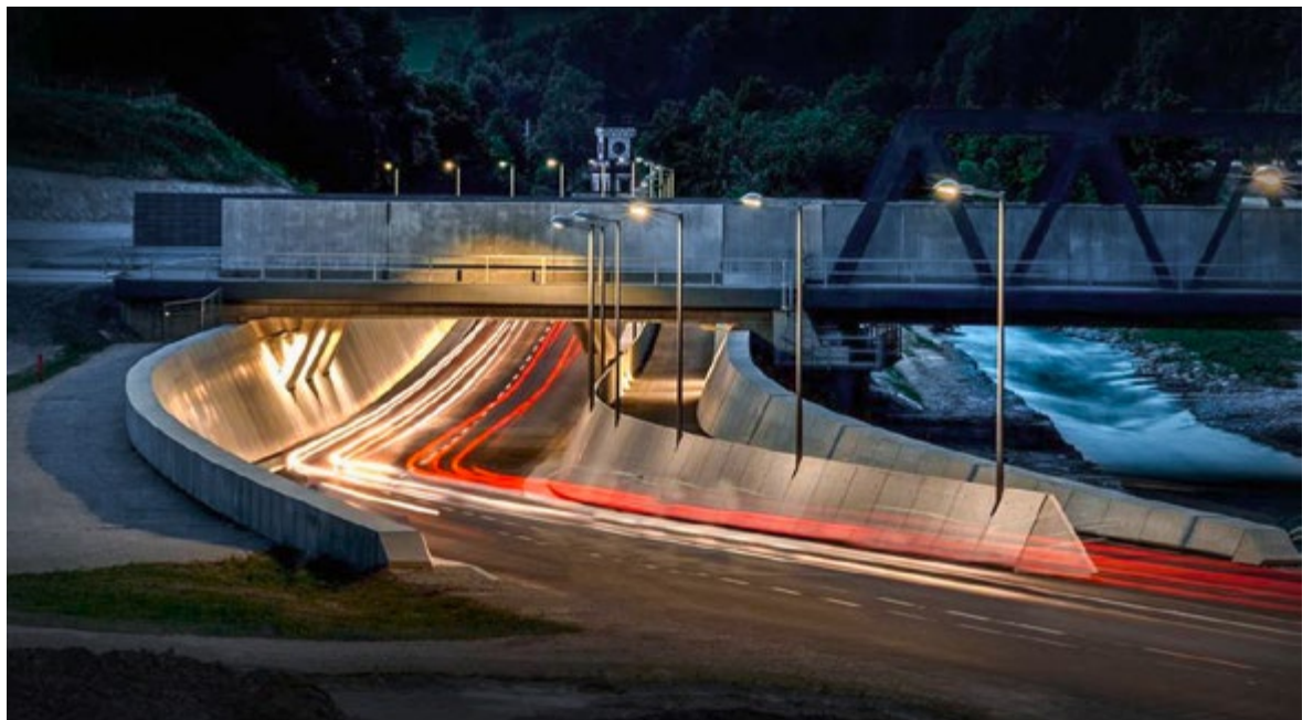
Perfekte Oberflächen gelangen bei dem Wannengebäude Gloggnitz – einem wichtigen Abschnitt des Semmering-Basistunnels.
